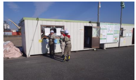
現場パトロールの様子(金城ふ頭)
