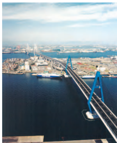
写真提供：中日本高速道路株式会社
