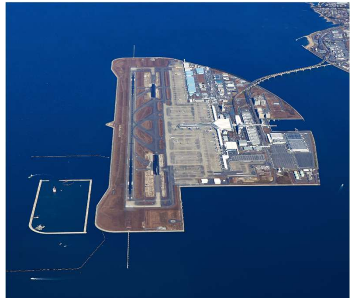
新土砂処分場の現況写真(R7.12)
