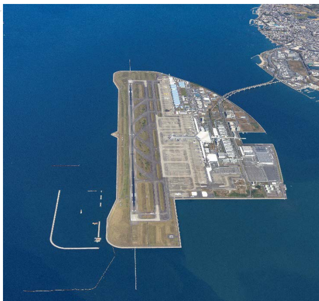
新土砂処分場の現況写真(R6.11)
