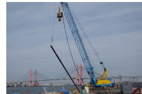
鋼管杭打設状況
