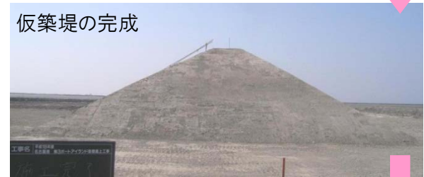
仮築堤の全周締切り完了(土砂処分開始)
